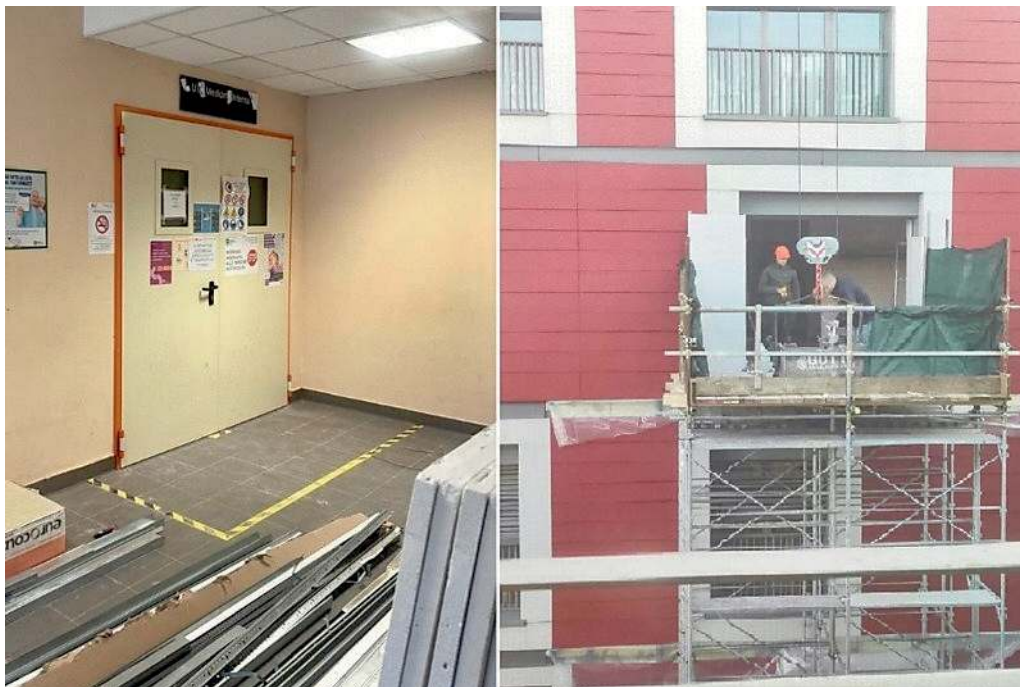
I lavori in corso all'ospedale di Voghera che hanno reso necessario spostare i pazienti di due reparti
